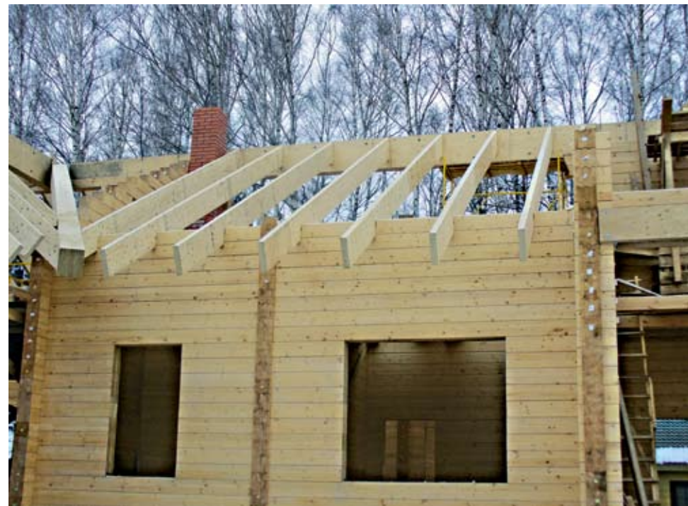
Два вида клееного бруса могут гармонично сочетаться в здании: стены из ламельного бруса, а перекрытия и стропила — из ЛВЛ
